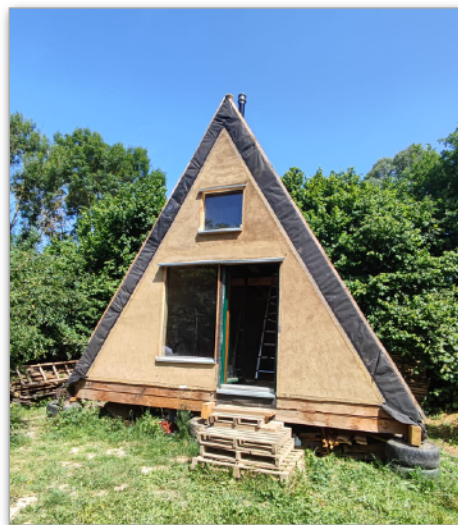
Maison en « A » au hameau du Placis à Saint-André-des-Eaux
